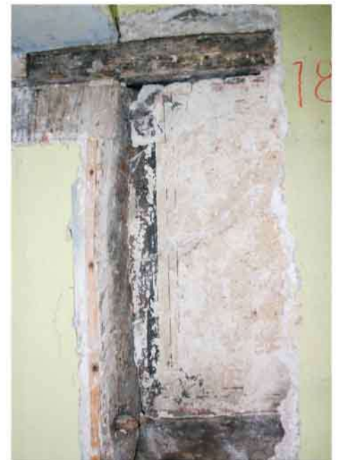
Wandbereich der Nordfassade im 1. Obergeschoss
