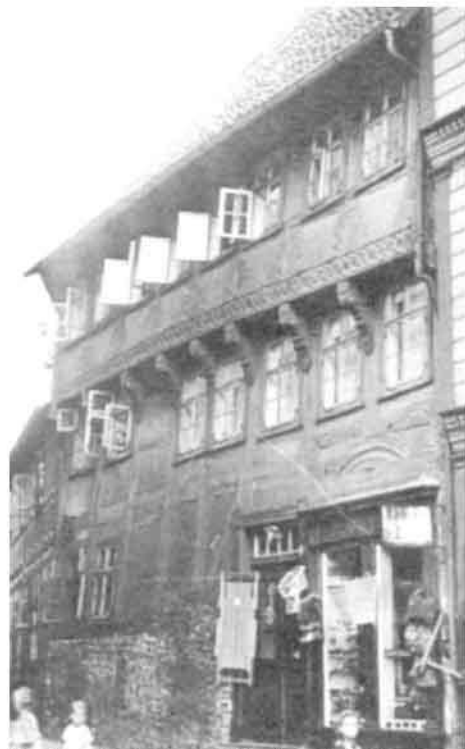
Nordfassade in der 1. Hälfte des 20. Jahrhunderts. An Stelle des Dielentors befindet sich ein 1878 eingefügtes Schaufenster.
