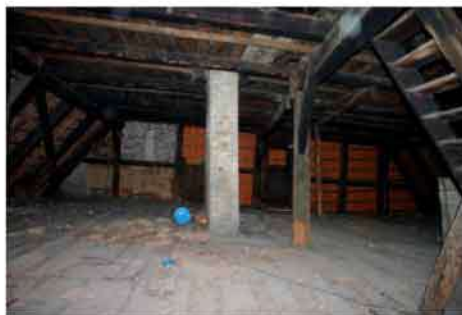
Blick in den Dachraum
